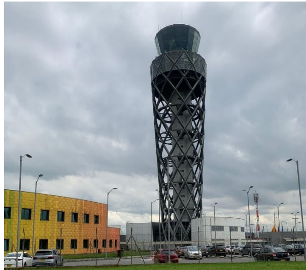
Fotografía 1. CGAC-Torre de control
