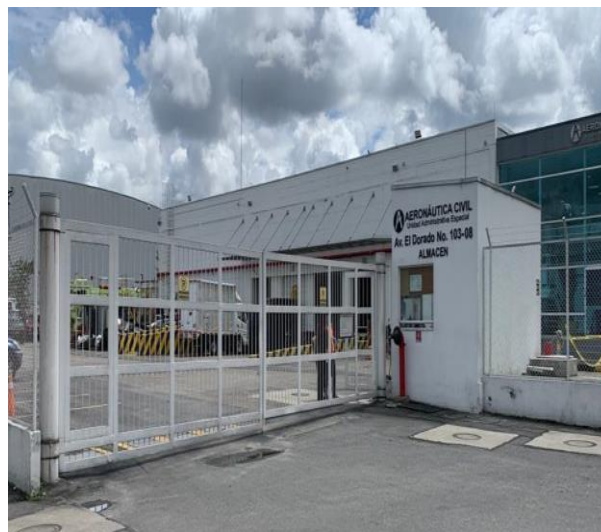
Fotografía 3. Nuevo Almacén De La Aeronáutica Civil (NAA)
